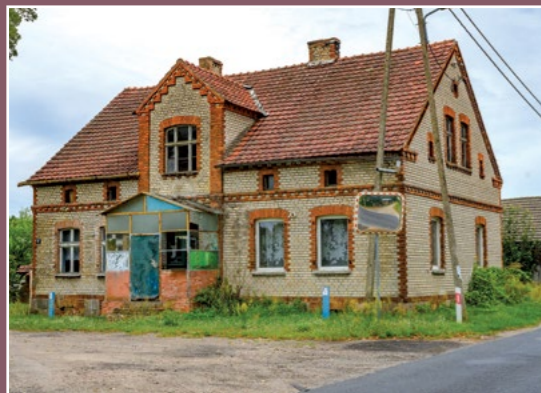
Dom w Kocieniu Wielkim Haus in Groß Kotten
