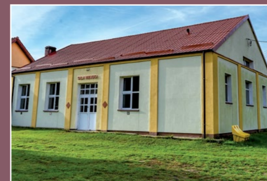
Świetlica w Dzierżążnie Małym Gemeinschaftshaus in Klein Drensen
