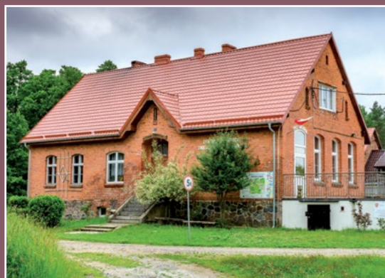
Dawna szkoła w Kuźniczce Ehemalige Schule in Kottenhammer
