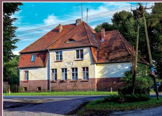
Dawna szkoła w Kocieniu Wielkim Ehemalige Schule in Groß Kotten
