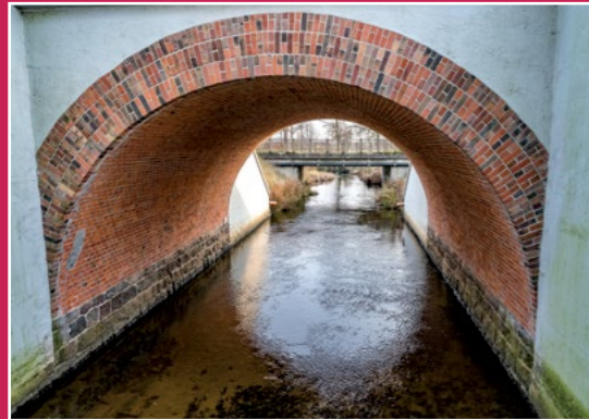
Mosty na Bukówce Brücken auf dem Buko - Fliess
