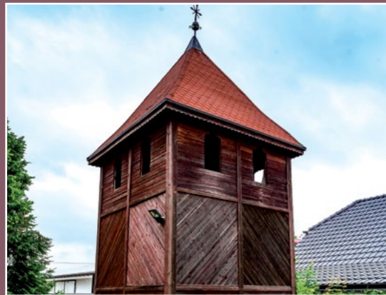
Dzwonnica w Białej Glockenturm in Behle
